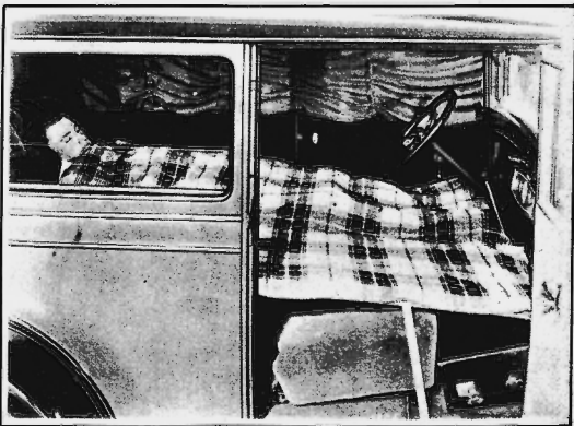
La última novedad en automovilismo son los "pullman-sedan" en los que el turista puede pasar la noche al borde de un camino con todo el confort que un hotel podría ofrecerle. Una serie de palancas articuladas permiten desplegar fácilmente el lecho y recogerle de nuevo a la hora de continuar el viaje.
